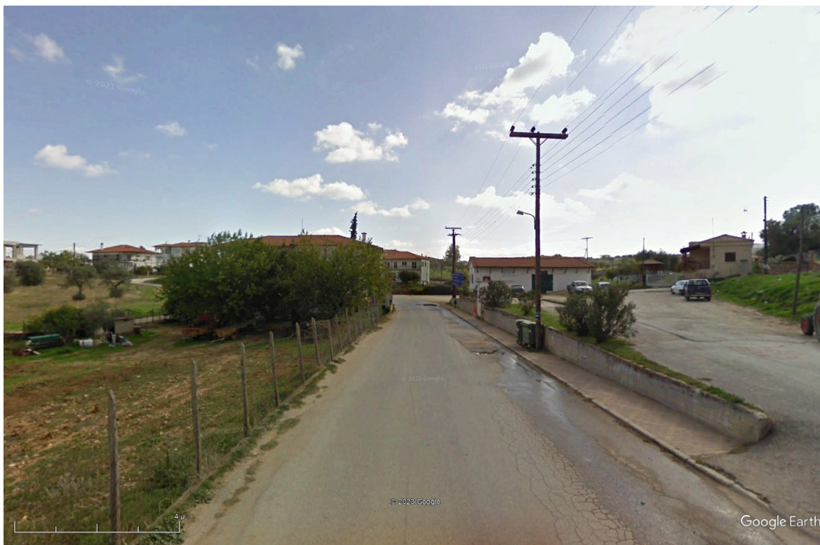
.Φωτο 4.3: Άποψη υφιστάμενης κατάστασης κλάδου 3
