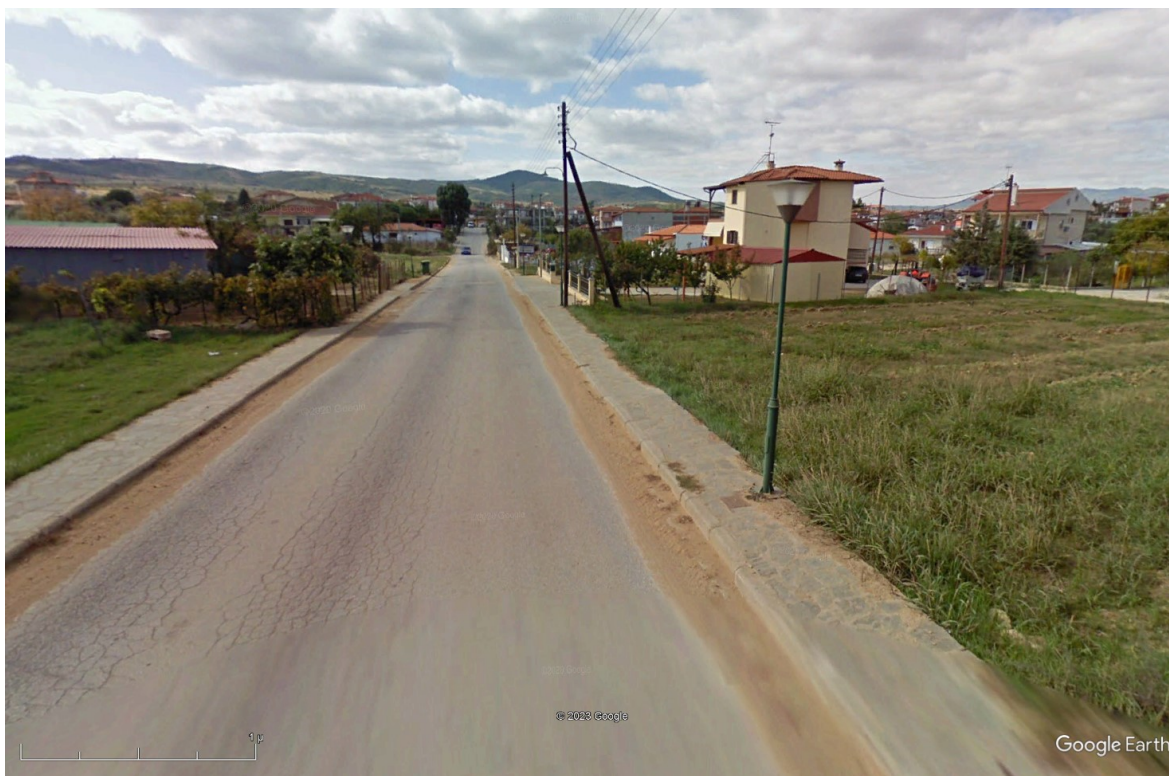
Φωτο 4.4: Άποψη υφιστάμενης κατάστασης κλάδου 4
