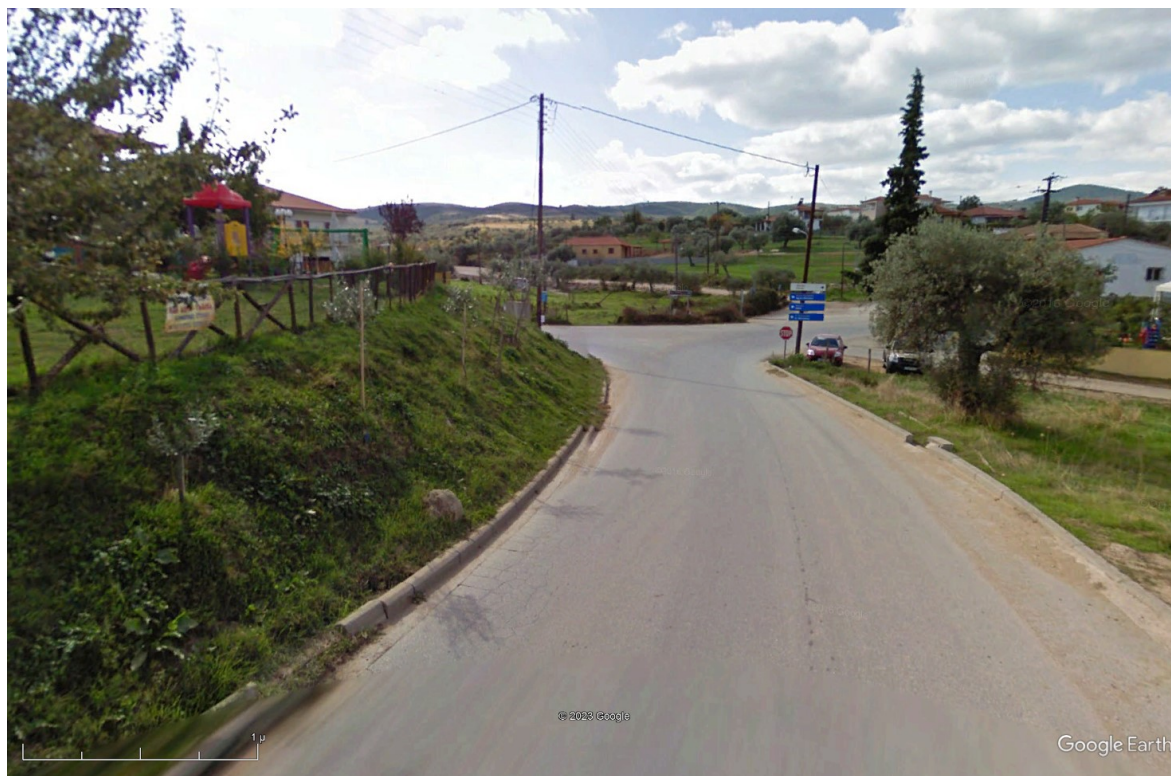
.Φωτο 4.2: Άποψη υφιστάμενης κατάστασης κλάδου 1
