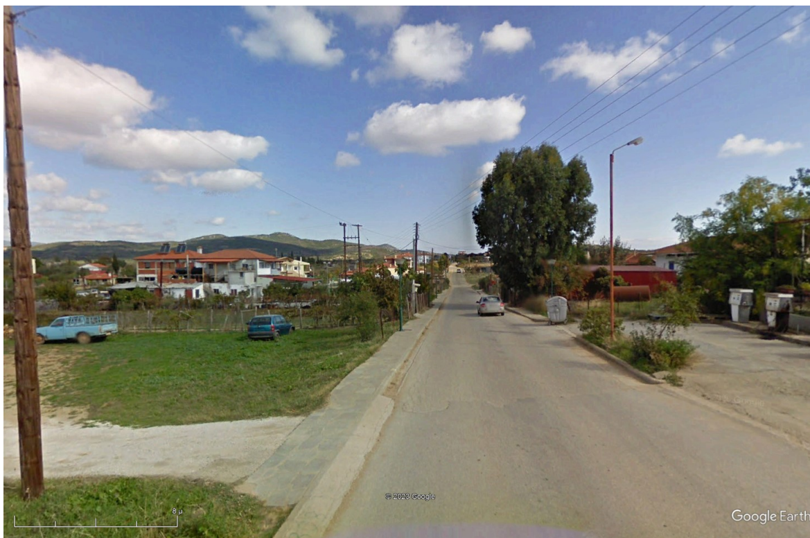
Φωτο 4.5: Άποψη υφιστάμενης κατάστασης κλάδου 5
