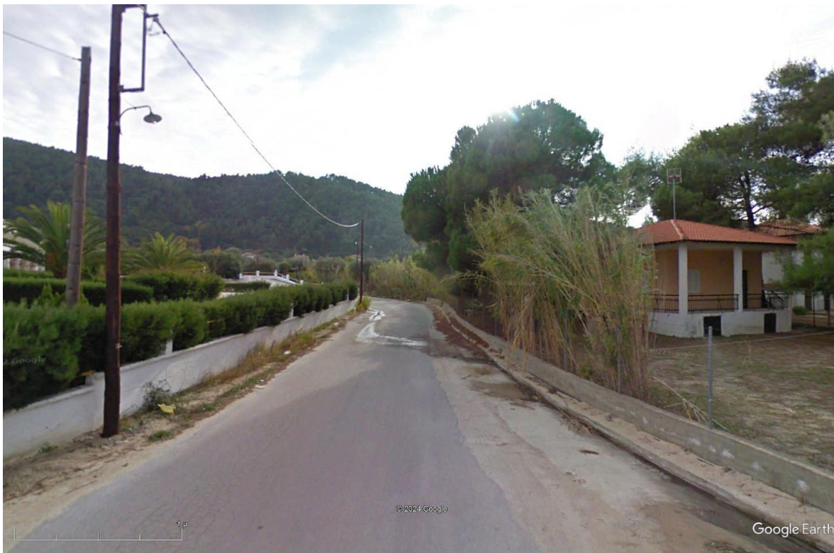
Φωτο 4.8: Άποψη υφιστάμενης κατάστασης κλάδου 0
