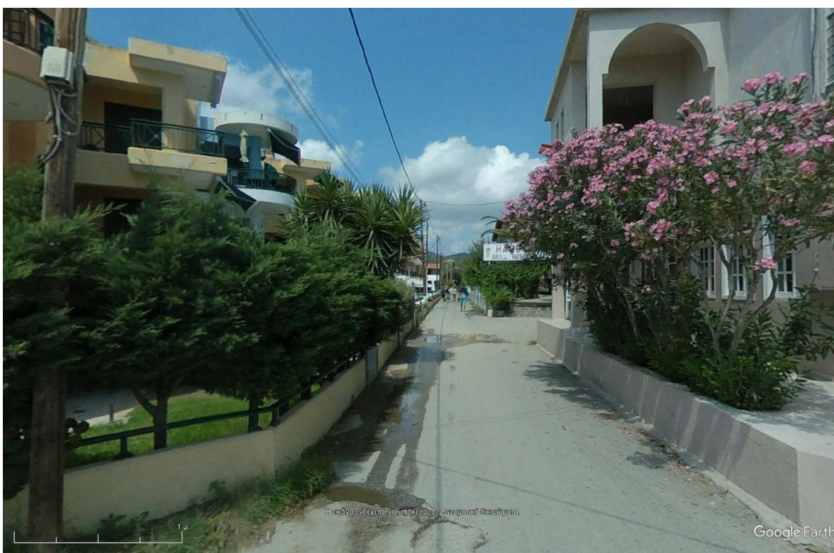
Φωτο 4.7: Άποψη υφιστάμενης κατάστασης κλάδου 1
