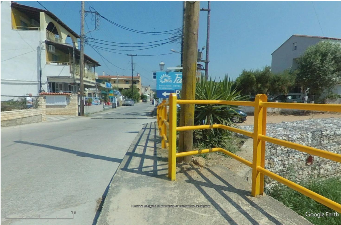
Φωτο 4.5: Άποψη υφιστάμενης κατάστασης κλάδου 0
