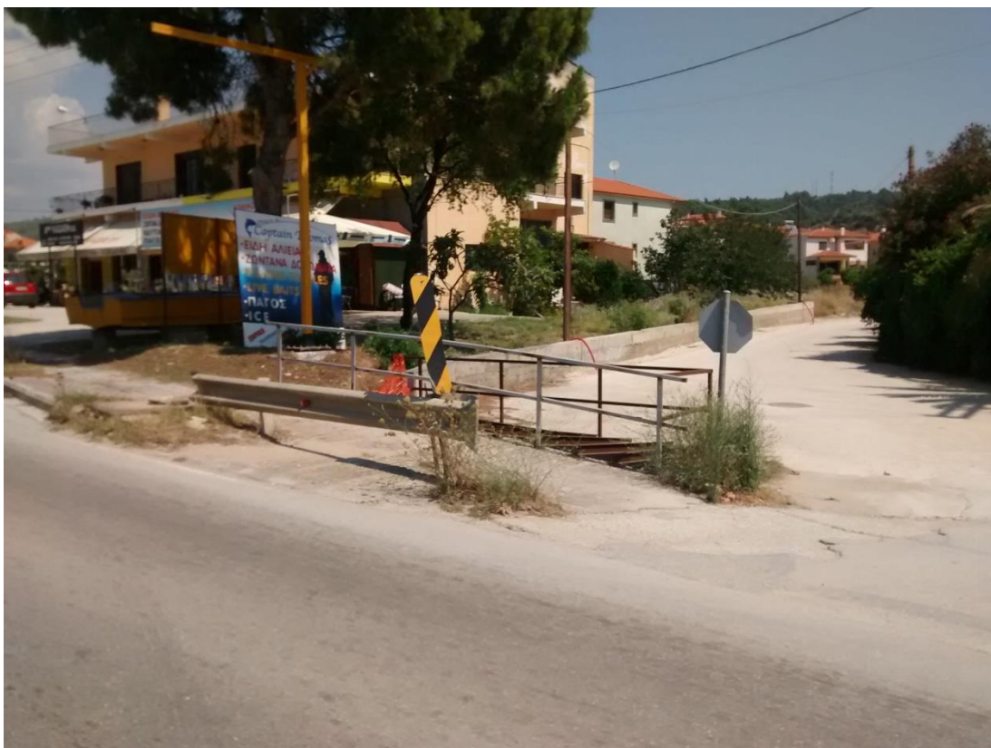
Φωτ. 2: Άποψη οδού στη διασταύρωση με το υπό μελέτη οδικό τμήμα, όπου θα καθαριρεθεί ο υφιστάμενος οχετός και θα αντικατασταθεί από νέο.
