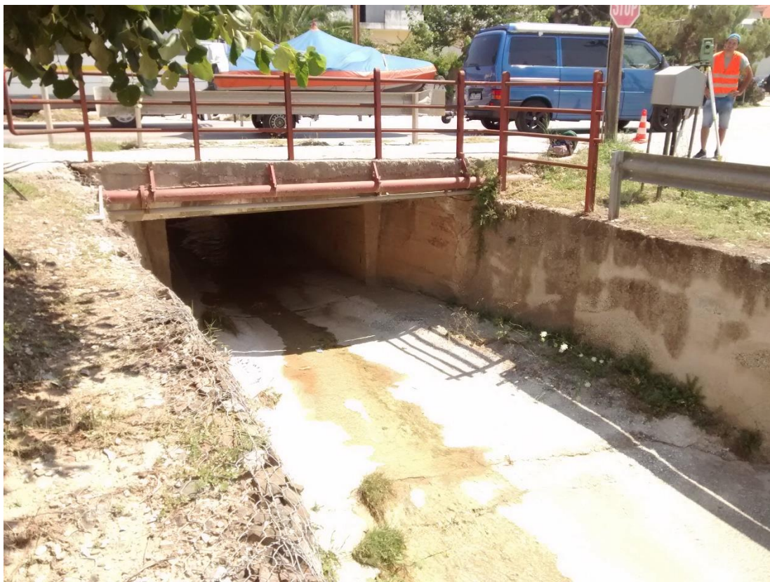
Φωτ. 3: Άποψη κιβωτοειδούς οχετού που θα καθαριρεθεί.
