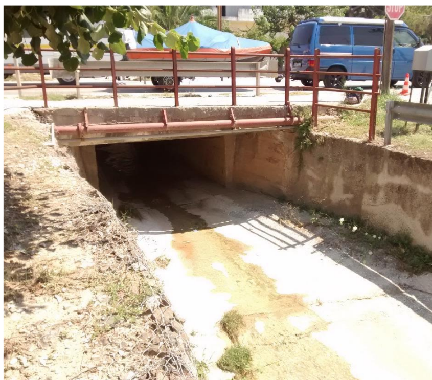
Εικόνα 12: Δεύτερο τεχνικό κατάληξης νέου δικτύου αποστράγγισης ομβρίων υδάτων μετά την είσοδο του οικισμού της Νικήτης και πριν τον μελλοντικό δεύτερο Κυκλικό Κόμβο (συμβολή Επ. Οδού Πολυγύρου – Αγ. Νικολάου με οδό Νεακίτου)
