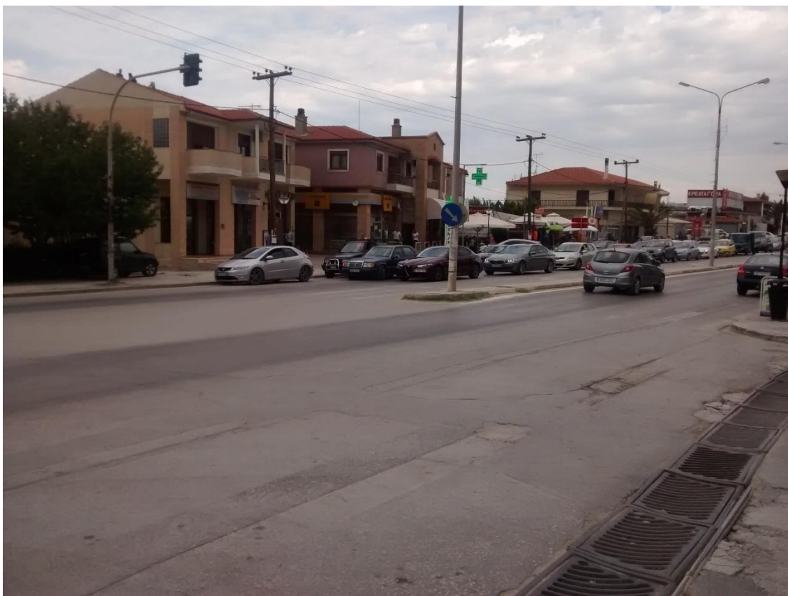
Φωτ. 4: Περιοχή ανάπτυξης δεύτερου κυκλικού κόμβου στη θέση υφιστάμενης διασταύρωσης της Επ. Οδού Πολυγύρου – Αγ. Νικολάου με την οδό Νεακίτου (περί την Χ.Θ. 0+897 της μελέτης).
