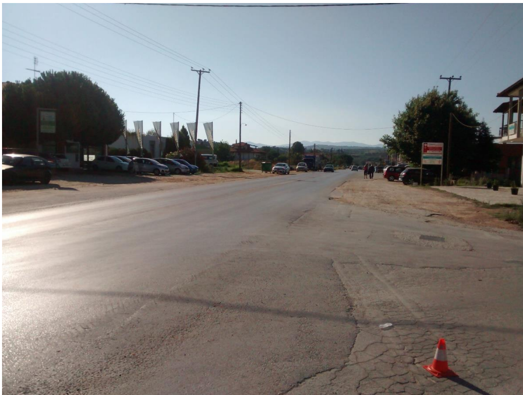
Φωτ. 6: Άποψη περιοχής ανάπτυξης τρίτου κυκλικού κόμβου, στη θέση της υφιστάμενης διασταύρωσης της Επ. Οδού Πολυγύρου – Αγ. Νικολάου με την οδό που οδηγεί από το Δημοτικό στάδιο Νικήτης προς την παραλία και αντίστροφα, περί τη Χ.Θ. 1+283.
