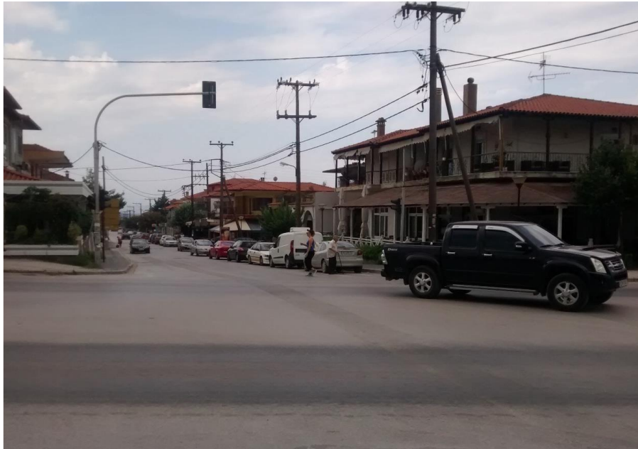
Εικόνα 13: Τοποθεσία τρίτου τεχνικού κατάληξης νέου δικτύου αποστράγγισης ομβρίων υδάτων (υπόγειο) στον μελλοντικό δεύτερο Κυκλικό Κόμβο (συμβολή Επ. Οδού Πολυγύρου – Αγ. Νικολάου με οδό Νεακίτου). Την οδό Νεακίτου διήκει υπόγειος οχετός από Οπλισμένο Σκυρόδεμα στον οποίο θα καταλήγει μέρος των ομβρίων της Επ. Οδού Πολυγύρου – Αγ. Νικολάου
